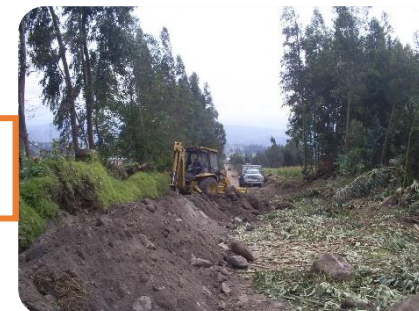
Adecuamientos de caminos
