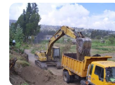
Retiro de escombros con maquinaria contratada
