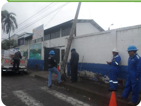
Cambio de postes
