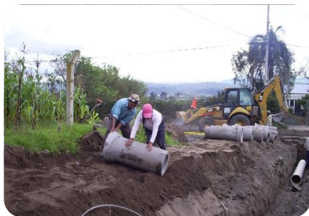
Excavación para el alcantarillado y colocación de los tubos
