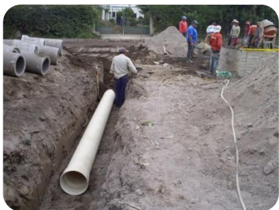
Excavación para el alcantarillado y colocación de los tubos
