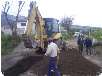
Excavación para el alcantarillado y colocación de los tubos
