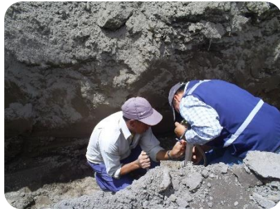
Excavación para el alcantarillado y colocación de los tubos
