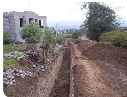
Excavaciones para la colocación de alcantarillados
